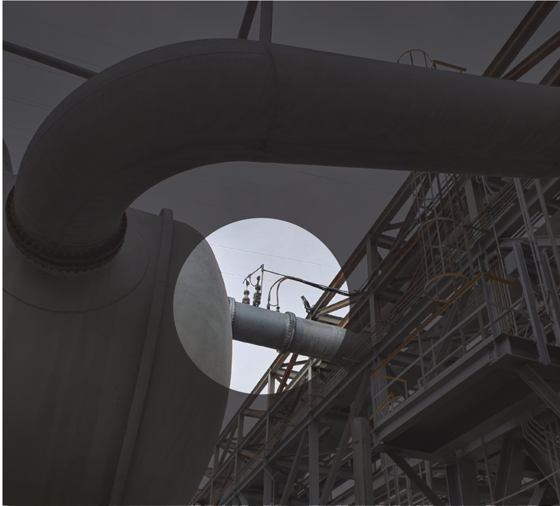
[Sample probe 설치 사진]
